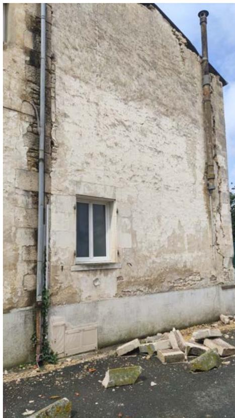
*Figure 2-35 : Endommagement hors plan au droit des fermes de toitures et fissuration de déversement à l'angle du bâtiment, dommage de degré 3, interaction possible entre deux corps de bâtiments (commune de Cram-Chaban).*
