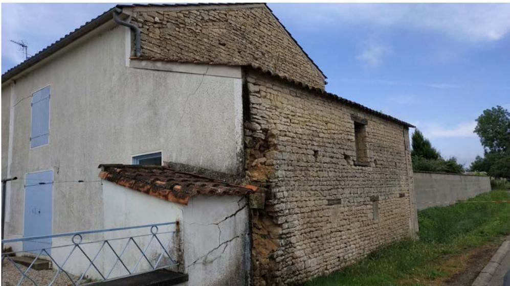
*Figure 2-29 : Dislocation à l'angle de deux pignons en pierres brutes d'un parement de pierres taillées (commune de Cram-Chaban).*
