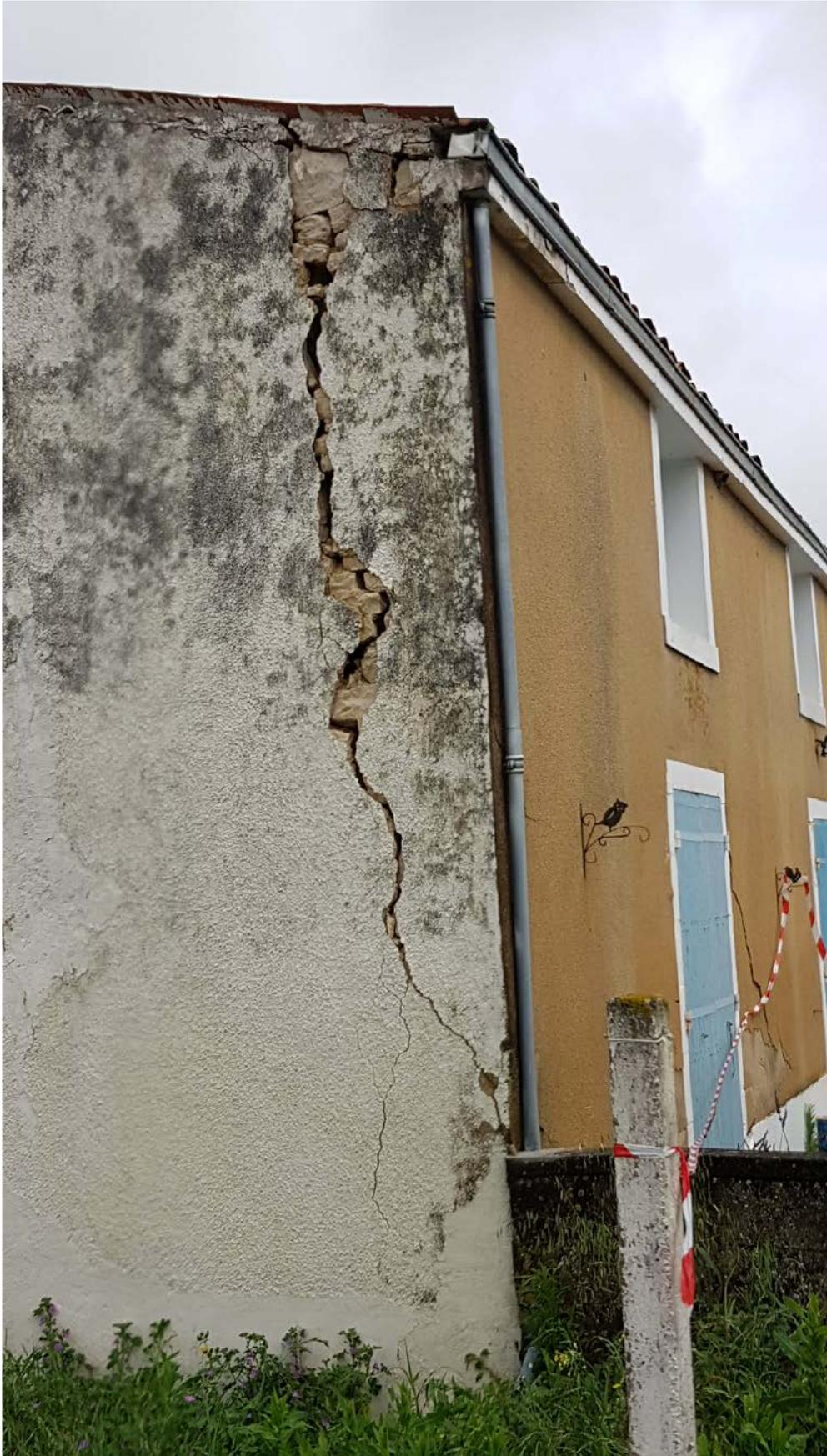
*Figure 2-30 : Fissuration de déversement sur un mur de façade en maçonnerie de pierres, dommage de degré 3, (commune de Cram-Chaban).*
