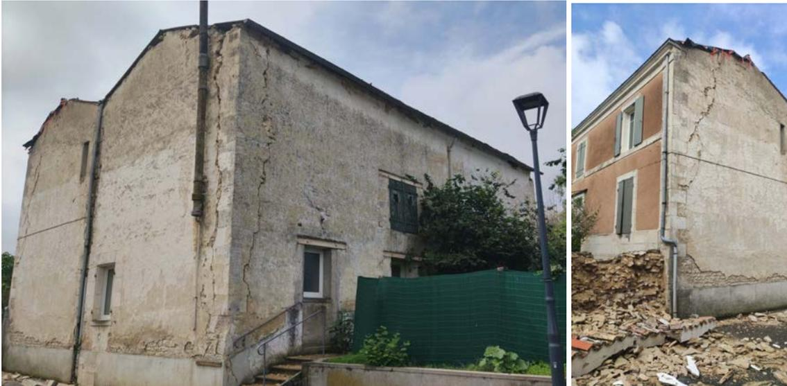
Figure 2-31 : Fissures de déversement le long des harpages d'angle en pierres massives sur un bâtiment en maçonnerie de pierres et endommagement des fermes de toiture (vues des 2 pignons, photo droite et gauche), dommage de degré 3 ; ainsi que l'effondrement d'un mur de propriété en maçonnerie de pierres tout venant (photo de droite - hors utilisation EMS-98), (commune de Cram-Chaban).
