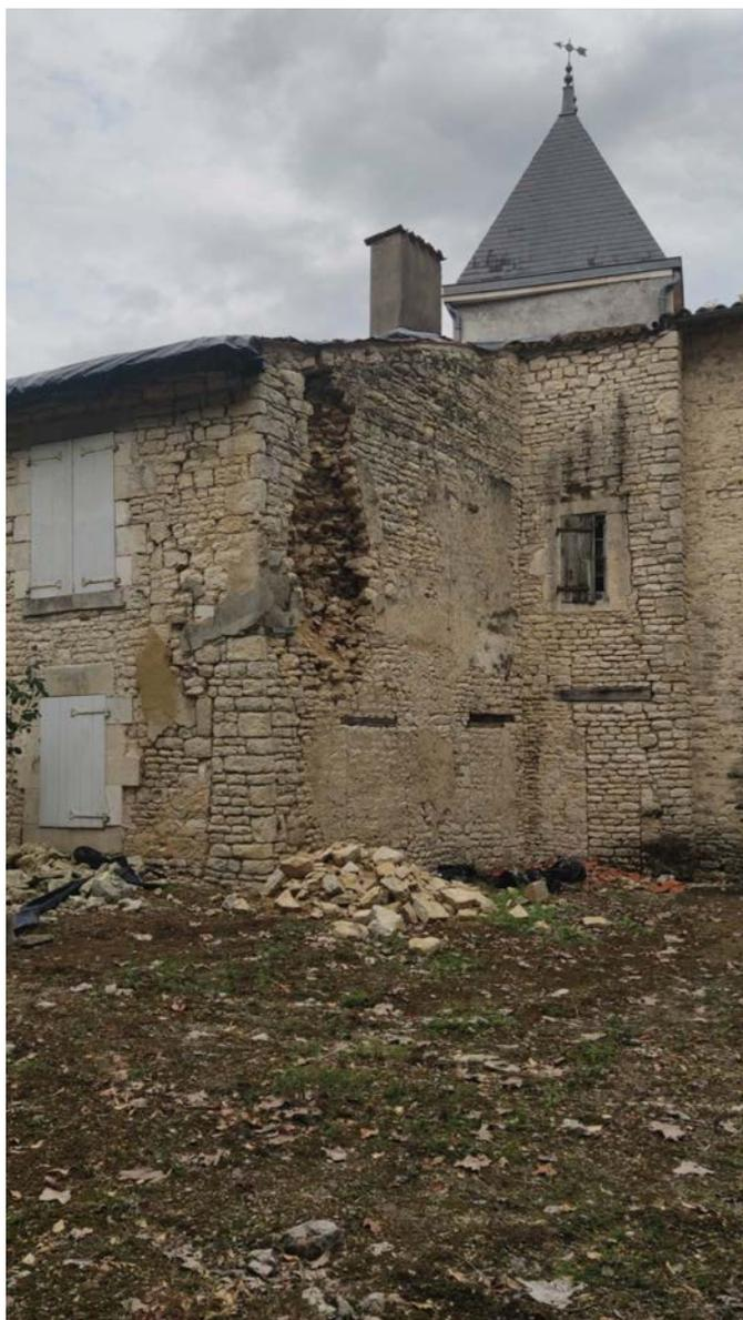
*Figure 2-21 : Dommage de degré 4, dislocation hors plan du parement en pierres taillées d'un bâtiment en maçonnerie de pierres, irrégulier en plan, perte de continuité de la maçonnerie et endommagement des fermes de toitures (commune de La Laigne, lieu-dit BeauLieu)*
