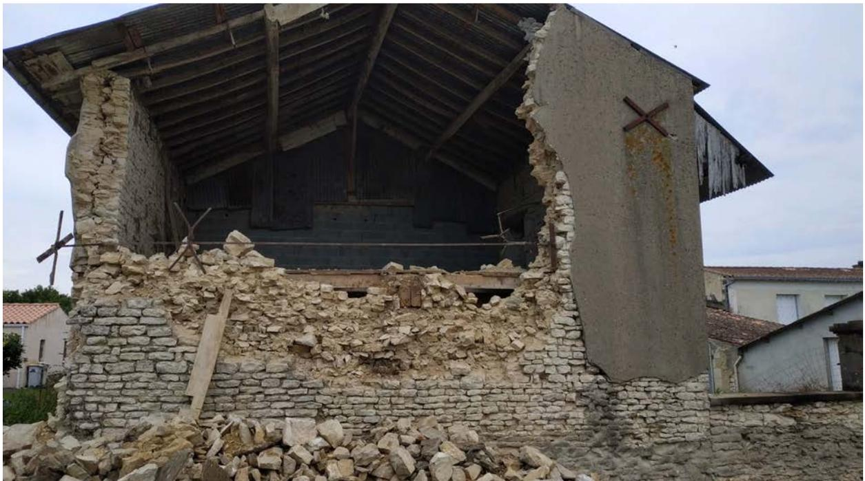
Figure 2-27 : Dommages de degré 4 , dislocation hors plan d'un mur porteur sur une grange en maçonnerie de pierres, la partie de gauche au droit de la planche verticale a été effondrée par les pompiers pour raison de sécurité (commune de Cram-Chaban)
