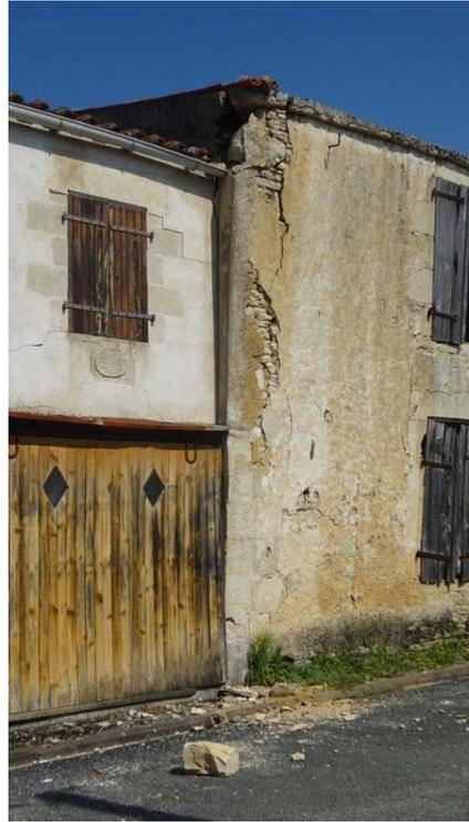
*Figure 2-15 : Dommages de degré 3, fissuration large en angle de bâtiment et poussée hors plan d'éléments de maçonneries de pierres, interaction entre deux bâtiments (commune de La Laigne).*
