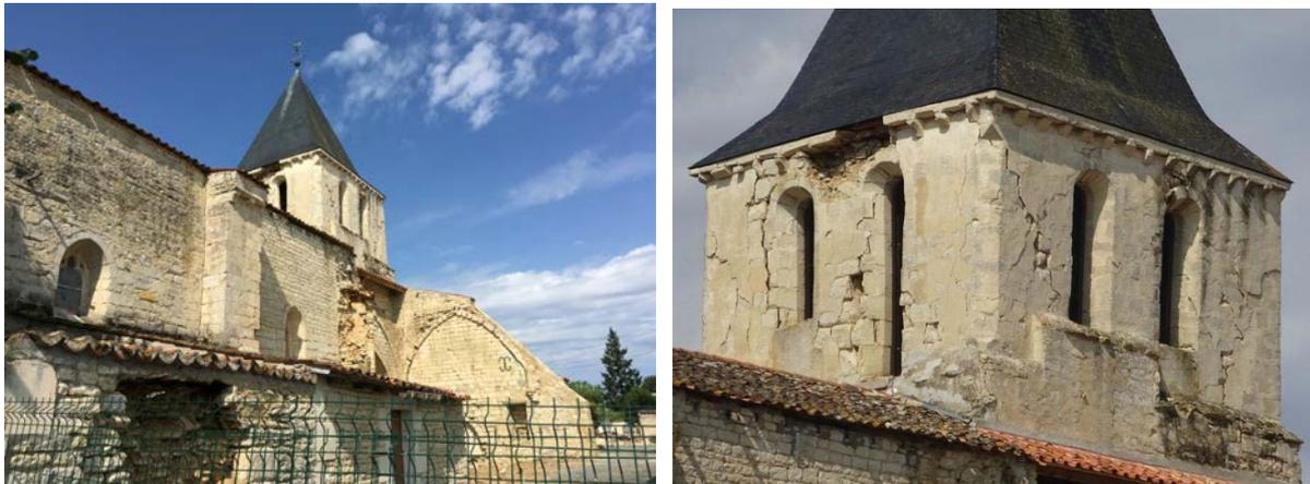
Figure 2-12 : Endommagement sérieux de la nef et du clocher de l'église en maçonneries de pierres, présentant des fissures en cisaillement et un endommagement hors plan au droit des fermes de toiture au-dessus des voûtes des ouvertures (commune de La Laigne).
