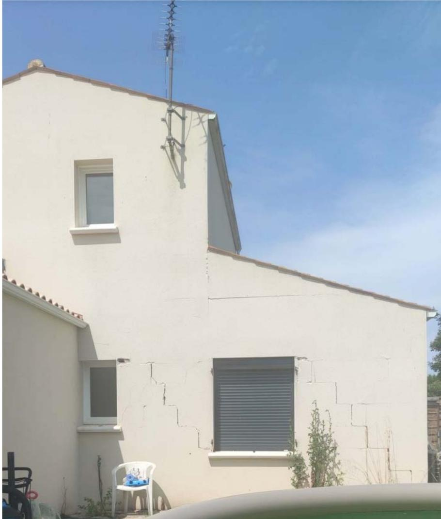
*Figure 2-19 : Endommagement de degré 3, fissuration entre les éléments préfabriqués de béton (agglos), (lotissement récent de la commune de La Laigne).*
