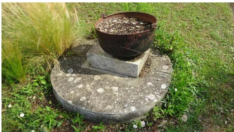
Figure 2-8 : Déplacement de plusieurs centimètres d'une dalle en béton et d'un vase en métal sur une plaque de collecteur des eaux usées (commune de La Laigne).
