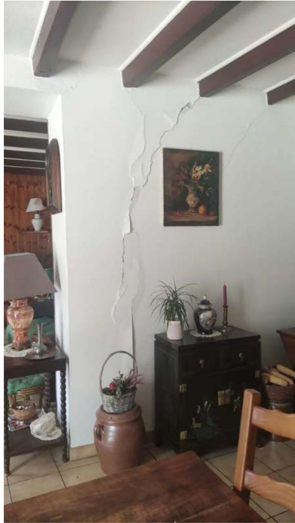
*Figure 2-28 : Exemple d'endommagement intérieur de degré 2 sur un mur en maçonnerie de pierres (commune de Cram-Chaban)*
