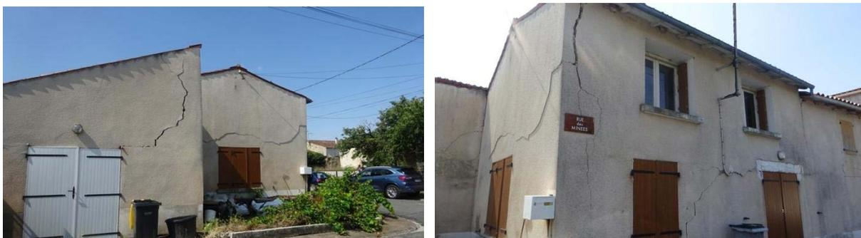
Figure 2-13 : Dommages de degré 4, fissuration larges et profondes dans la plupart des murs, perte de continuité de la maçonnerie (commune de La Laigne)
