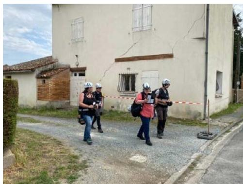
Figure 2-10 : Fissuration diagonale, endommagement de degré 2 et équipe d'experts du GIM (commune de La Laigne).
