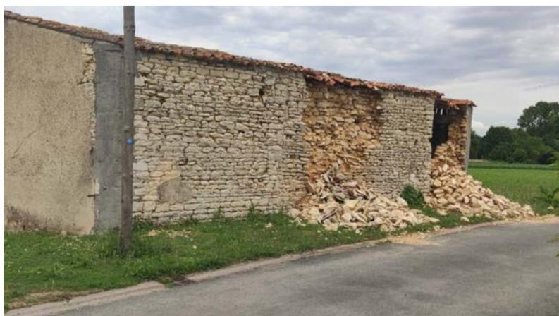
*Figure 2-22 : Dommages de degré 4, dislocation hors plan d'un mur porteur sur un bâtiment en maçonnerie de pierres (commune de La Laigne, lieu-dit Crépé)*
