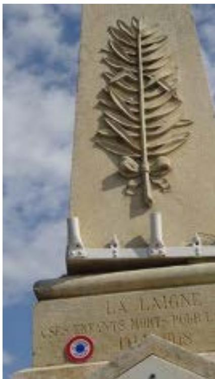
Figure 2-7 : Déplacement de la partie supérieure du monument aux morts par mouvement de rotation (commune de La Laigne).
