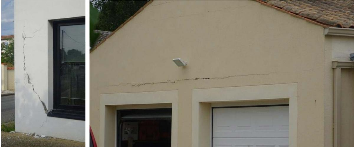
Figure 2-11 : Dommages de degré 2, fissuration d'éléments de maçonneries de béton (commune de La Laigne).
