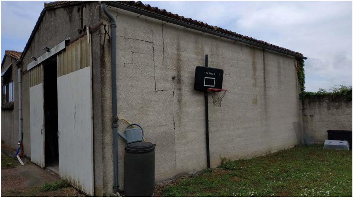
*Figure 2-36 : Endommagement de degré 2, fissuration entre les éléments préfabriqués de béton (agglos), (commune de Cram-Chaban).*
