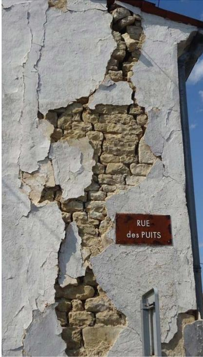
*Figure 2-14 : Dommages de degré 3, fissuration large et début de poussée hors plan d'éléments de maçonneries de pierres (commune de La Laigne).*
