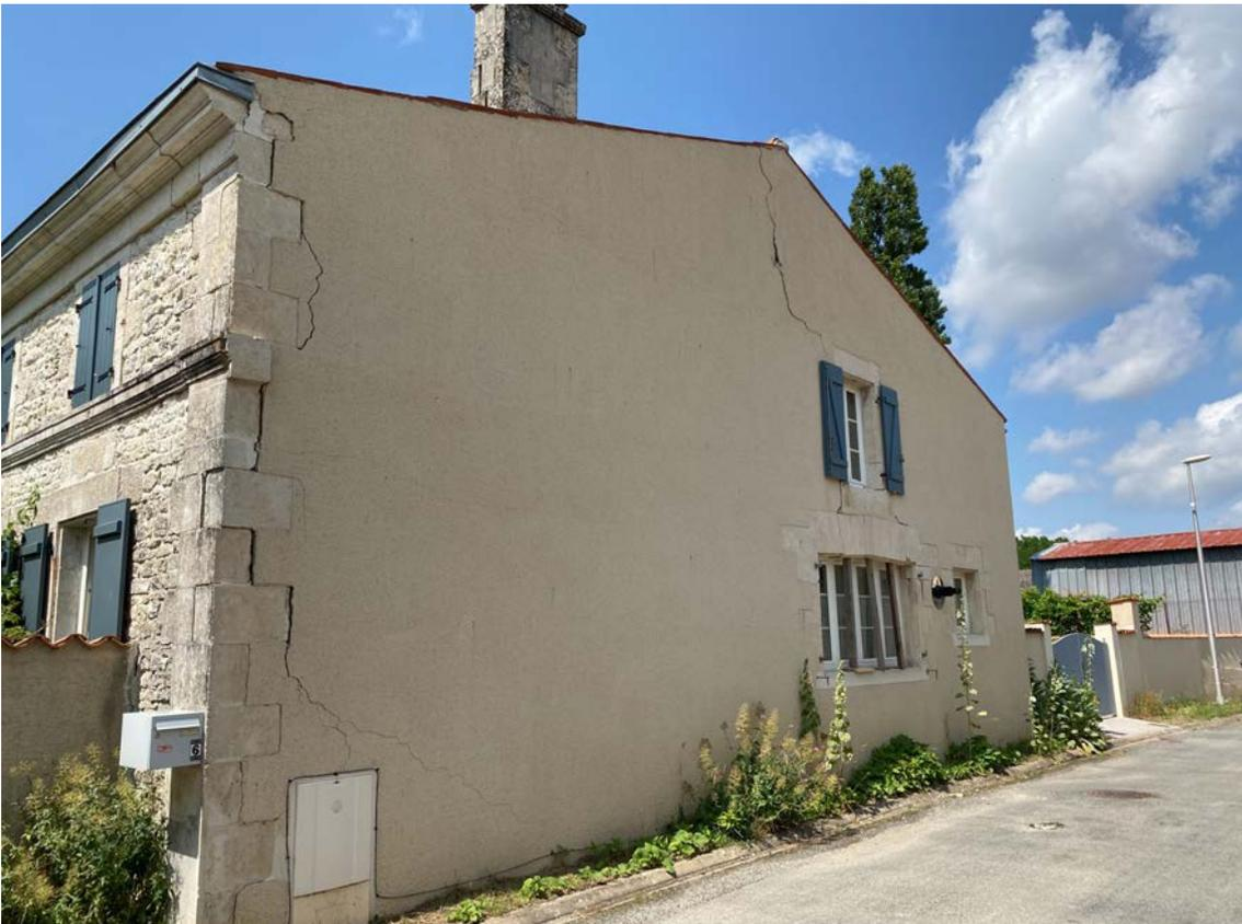
Figure 2-32 : Fissuration le long du harpage d'angle en maçonnerie de pierres massives sur un bâtiment en maçonnerie de pierres, dommage de degré 3 (commune de Cram-Chaban – lieu dit Le Peu).
