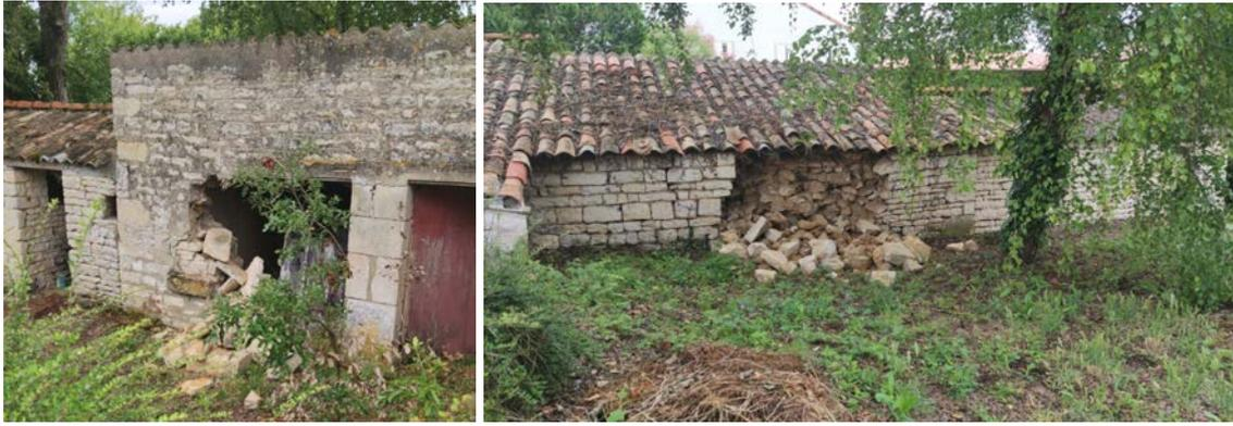
*Figure2-17 : Exemple de dommages de degré 4, ouvertures hors plan de murs porteurs sur des bâtiments en maçonnerie de pierres, vues des façades opposées (commune de La Laigne).*
