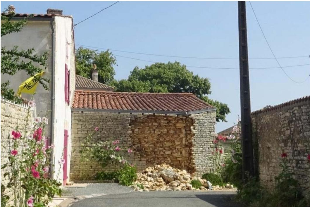
*Figure 2-16 : Dommages de degré 4, défaillance sérieuse d'un mur en maçonnerie de pierres (commune de La Laigne).*
