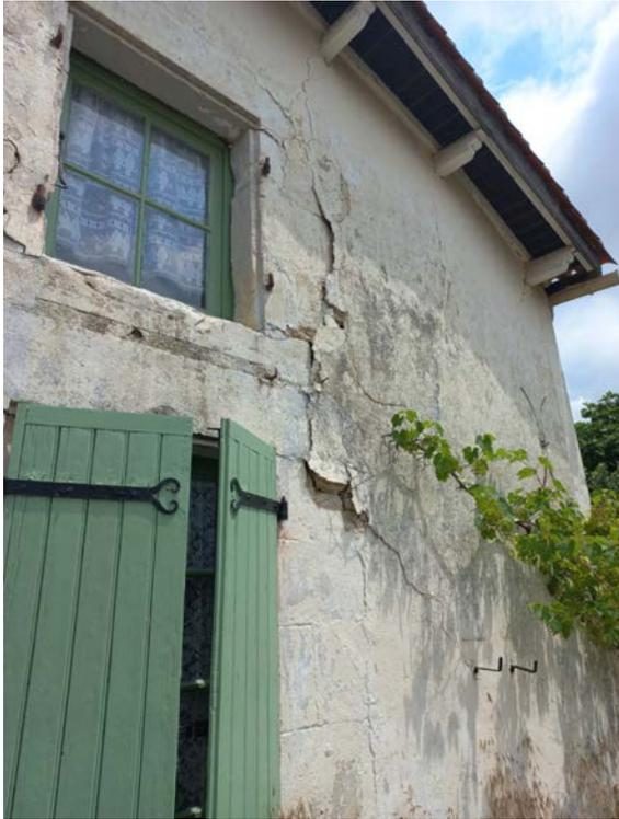
*Figure 2-33 : Fissuration de façade et début de poussée sur l'appareillage du mur en pierres brutes au droit de pierres taillées plus massives, dommage de degré 3 (commune de Cram-Chaban).*
