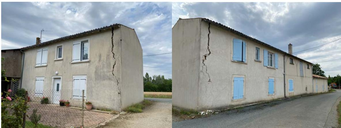
*Figure 2-20 : Endommagement de degré 3, perte de continuité entre les murs extérieurs, la partie droite du bâtiment ne semble pas avoir subi de dégâts aussi sérieux (commune de La Laigne, lieu-dit Le Moulin), vues avant et arrière du bâtiment.*
